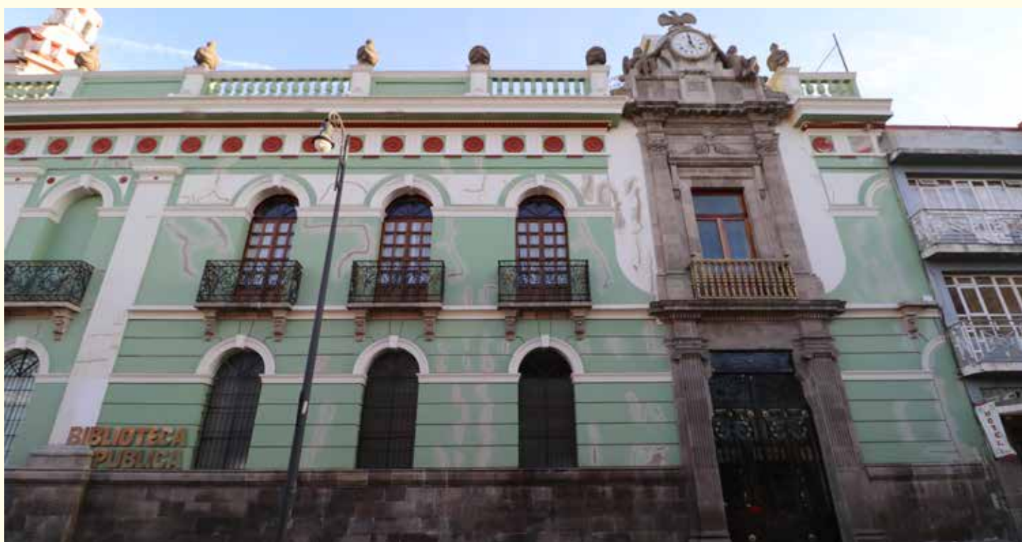
Vista exterior de la biblioteca Ignacio Zaragoza, cuyo edificio albergó el hospital de Belén en Puebla. Foto: Guillermo Reynoso Sparrow.
