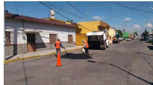
Se arreglo el adoquín de la Calle 47 sur entre las calles 13 y 15 Poniente de la Colonia Ampliación Reforma Sur, ya que este se encontraba en mal estado
