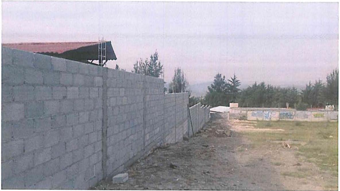
36 castillos, 19 tipo columnas. Y 230 metros lineales de cadena.
