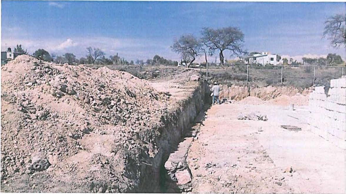
Se construyen 110 metros lineales tanto de mampostería o cimientos, de 90 a 1.10 mts. De altura, Según se requiera.
