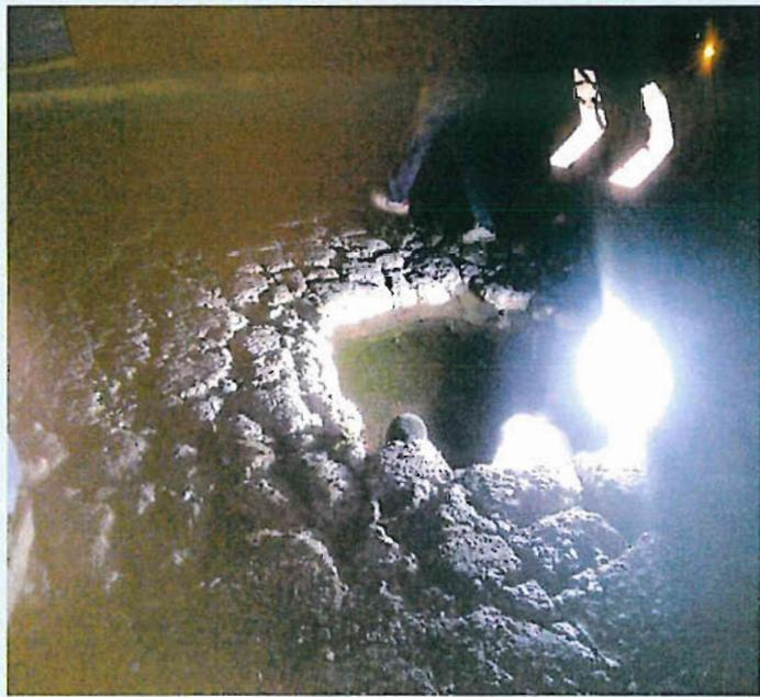
calle Emiliano Zapata col Polideportivo arreglando la tubería , que colapso debido al peso del trasporte y deslave por la corriente pluvial
