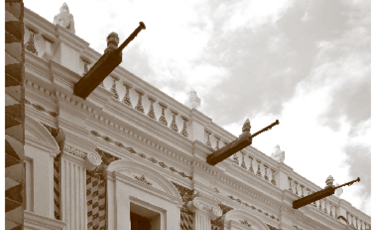
Los muros de las fachadas oriente, sur y norte están cubiertos con petatillo y mayólica, son rematadas por balaustradas coronadas con florones
