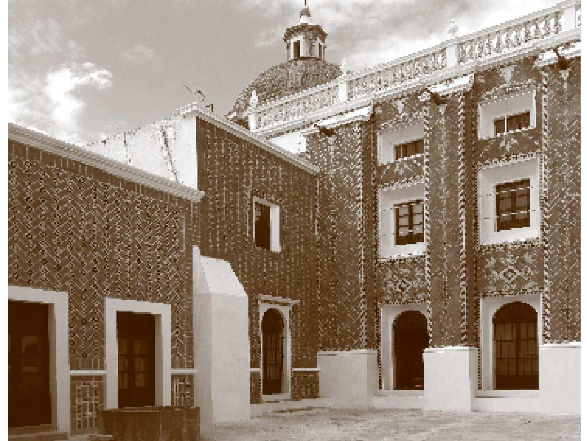
Fachada norte y poniente donde se puede apreciar la cúpula que cubre una antigua capilla de la ex Casa de Ejercicios ubicada en el segundo nivel
