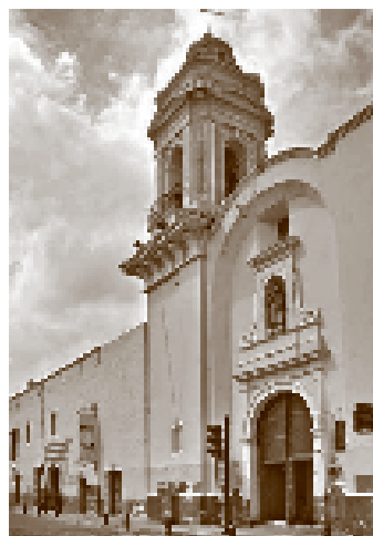
Vista del Hospital de San Roque
