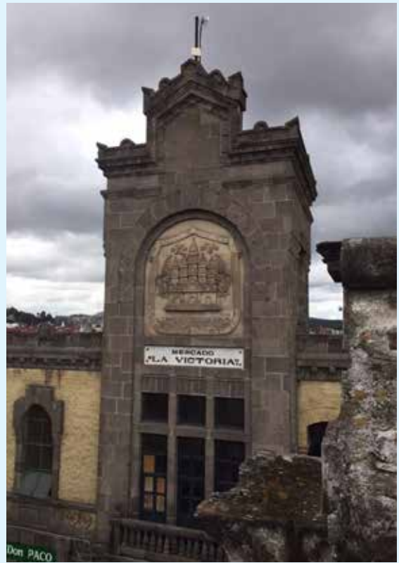
3 Norte 440. Cambian los sistemas constructivos que por siglos han dominado, redefiniendot las líneas, luces y sombras de la imagen urbana ya en el siglo XX..
