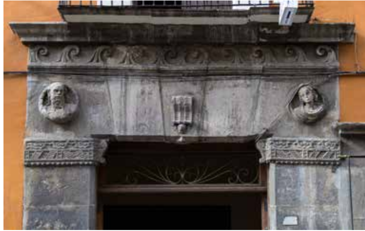
Casa de las Cabecitas, uno de los pocos ejemplos de arquitectura civil del siglo XVI, ubicada a un costado del templo de San Agustín, construida para residencia del conquistador y encomendero de Totimehuacan Alonso Galeote. Foto: Héctor Crispín
