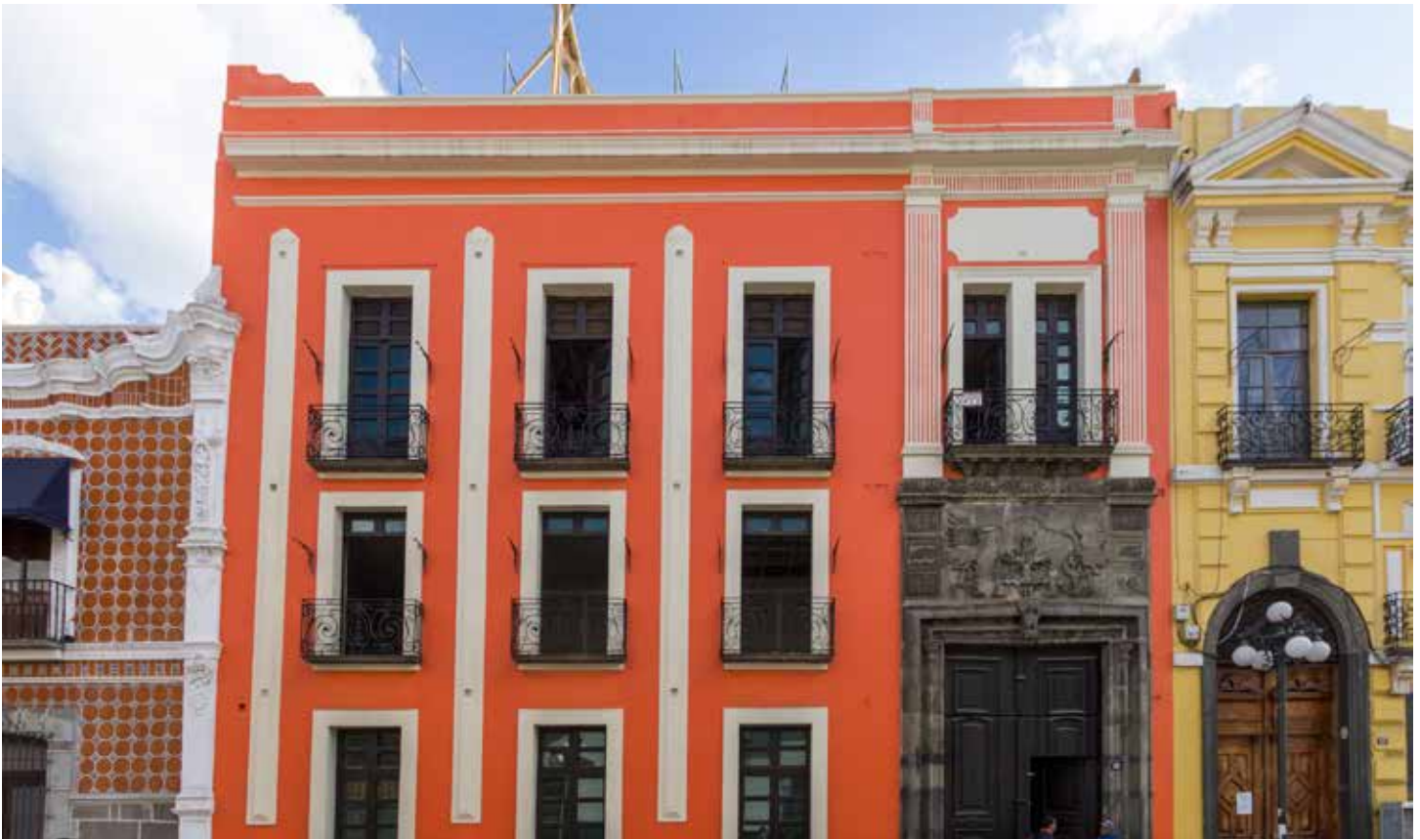
En la imagen, la Casa de las Cigüeñas del siglo XVII (en proceso de restauración), ubicada en la calle del Correo Viejo, actual 5 Poniente número 125, denominada así por los motivos labrados en su hermoso pórtico tallado en cantería. Foto: Héctor Crispín.
