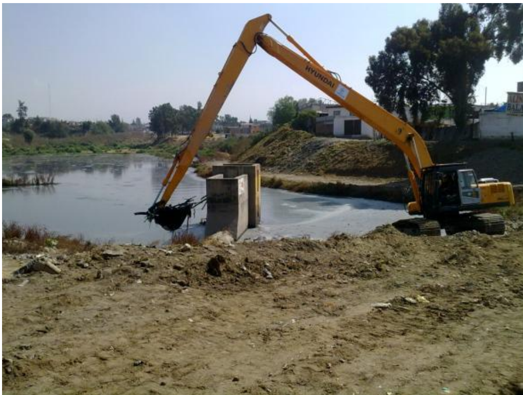
Operativo de Limpieza en el Vaso Regulador Puente Negro.
