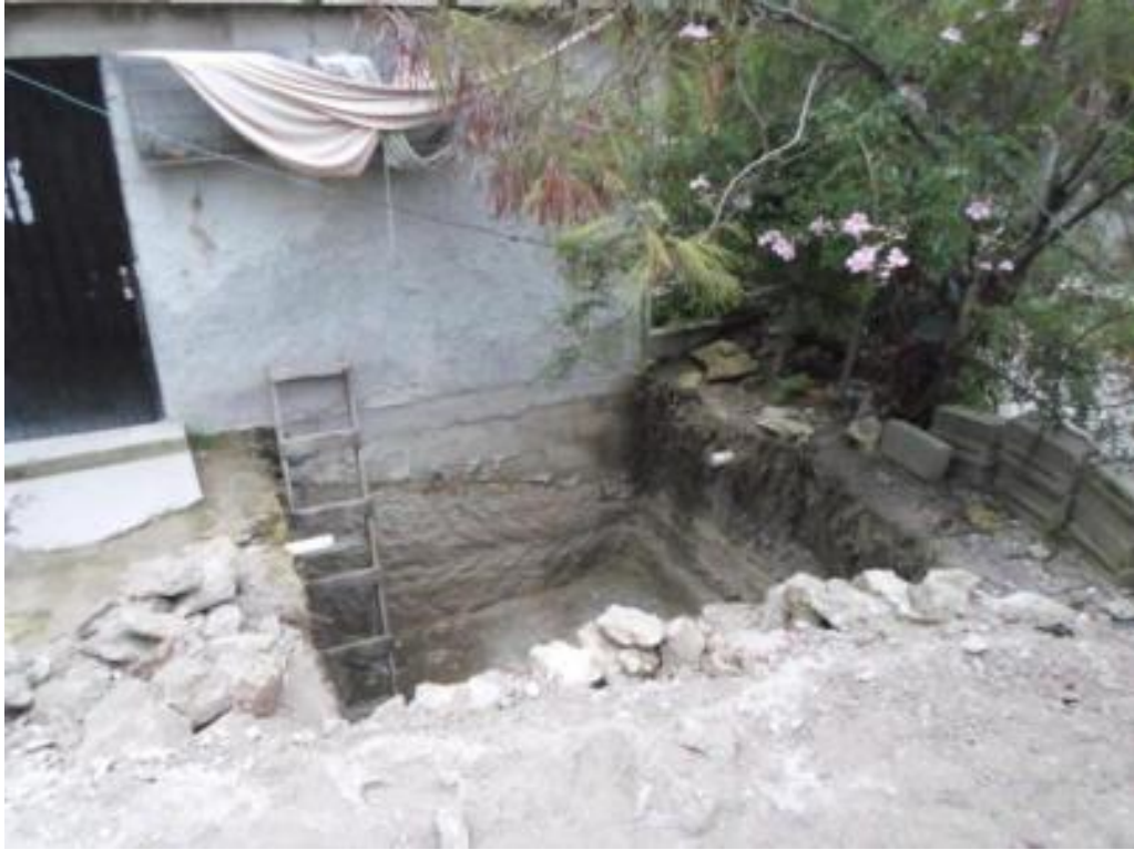
Construcción de cisternas para captación de agua pluvial en Rosario La Huerta.
