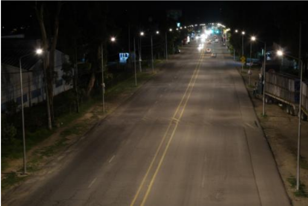
Nuevo Alumbrado Público instalado en el Antiguo Camino a Manzanilla, dentro de la Junta Auxiliar La Resurrección (Se instalaron 83 postes nuevos, más 24 luminarias en postes existentes. Tenían 40 años sin alumbrado).
