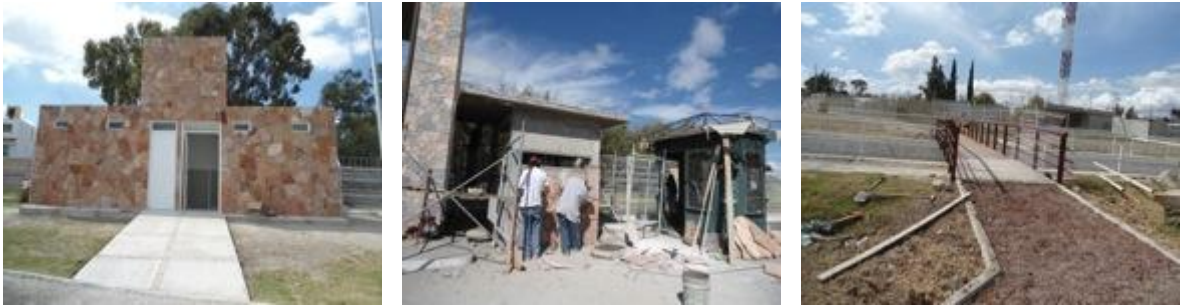
Mejora de Infraestructura: Obras Complementarias
