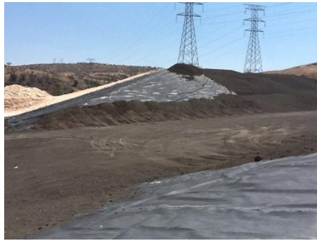
Impermeabilización Celda B2012
