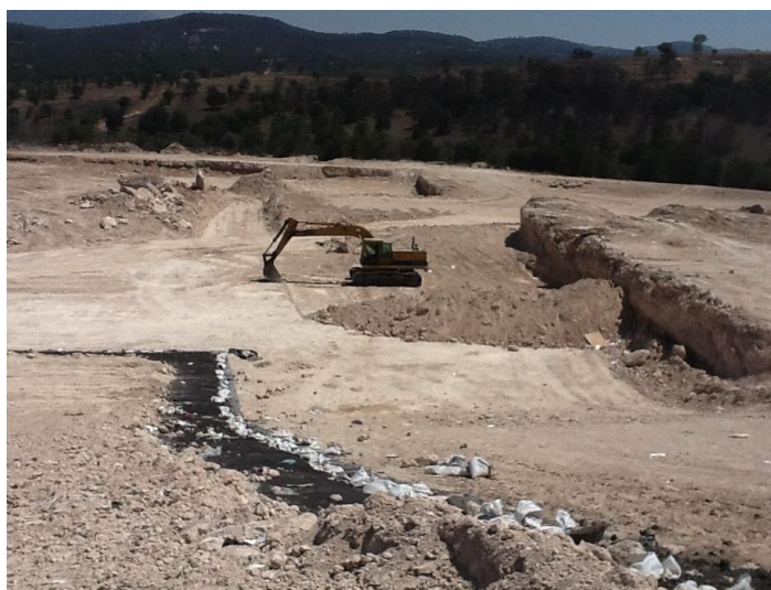
Construcción Celda B2012
