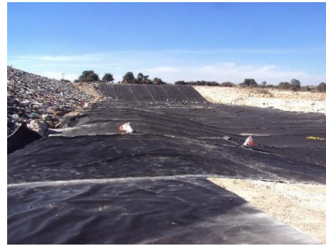
Impermeabilización Celda B2012
