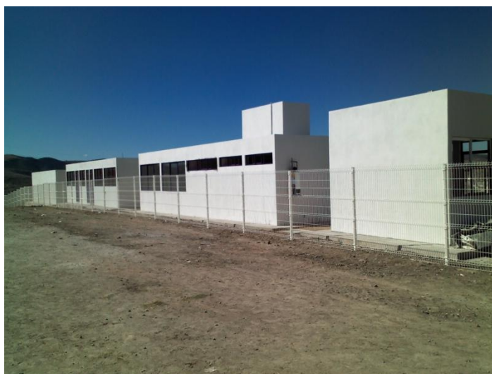
Construcción Nueva Estancia Canina Municipal
