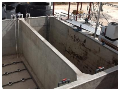
Construcción de Planta de Lixiviados
