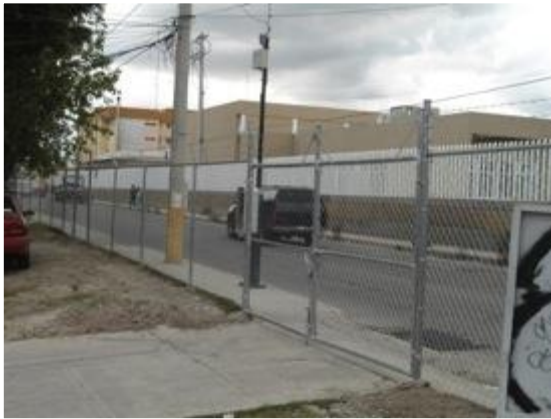
U.H. Agua Santa Ahora Instalación de malla ciclónica y reparación de banqueta
