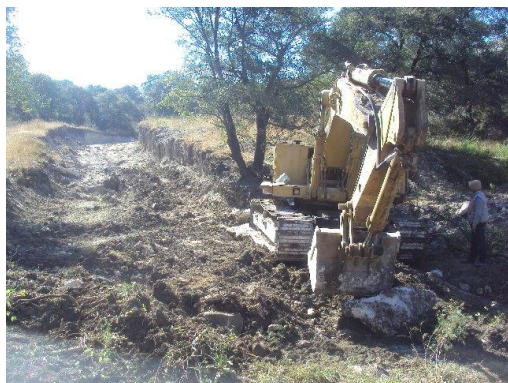
Inicio de los Trabajos para el Embovedamiento del Cauce del Arroyo Temporal
