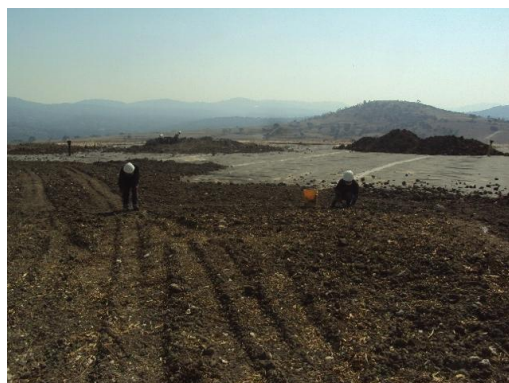
Cubierta de Tierra Vegetal Área A del Relleno Sanitario
