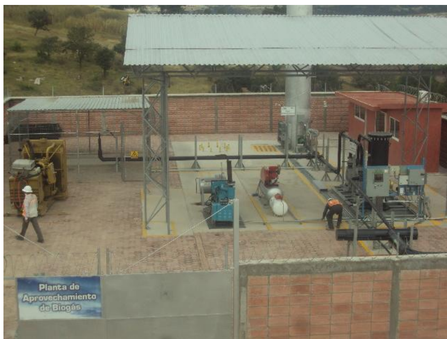
Planta de Biogás
