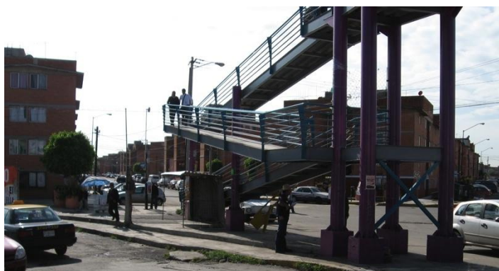
Antes de la Construcción de Barda Perimetral U.H. San Bartolo
