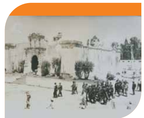
Recorrido de autoridades por el fuerte de Loreto, se observan el estado de deterioro del templo, antes de las obras realizadas con motivo del Centenario de la batalla del 5 de mayo. 1962
