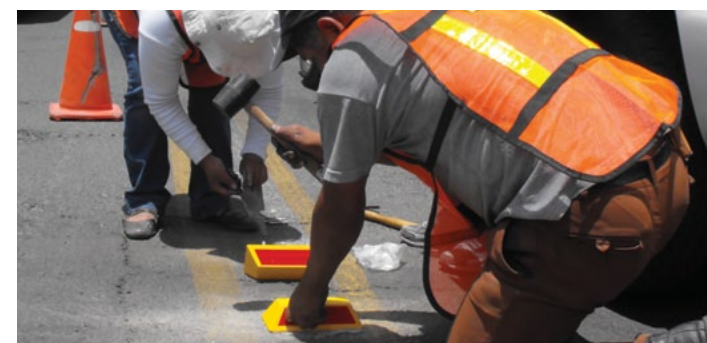
Colocación de señalética vertical.
