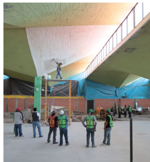
Construcción del Centro de Atención Múltiple Municipal.
