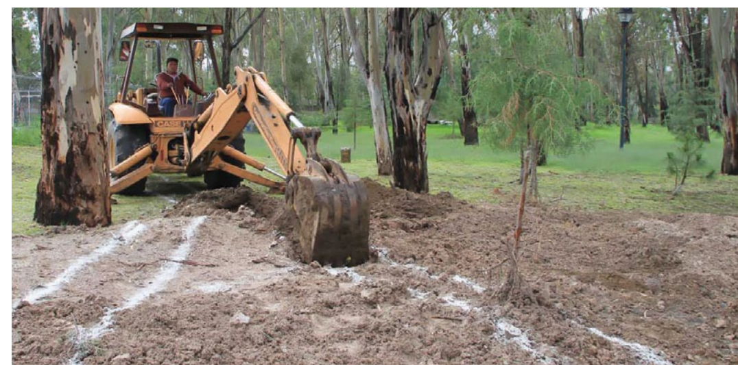
Trabajos para llevar agua potable.
