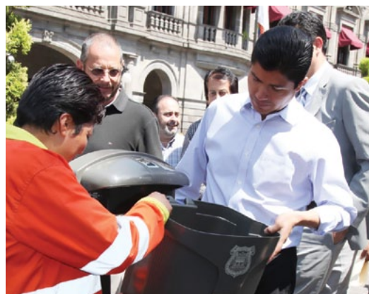
Instalación de botes papeleros.
