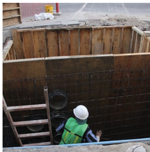
Obras del alcantarillado.
