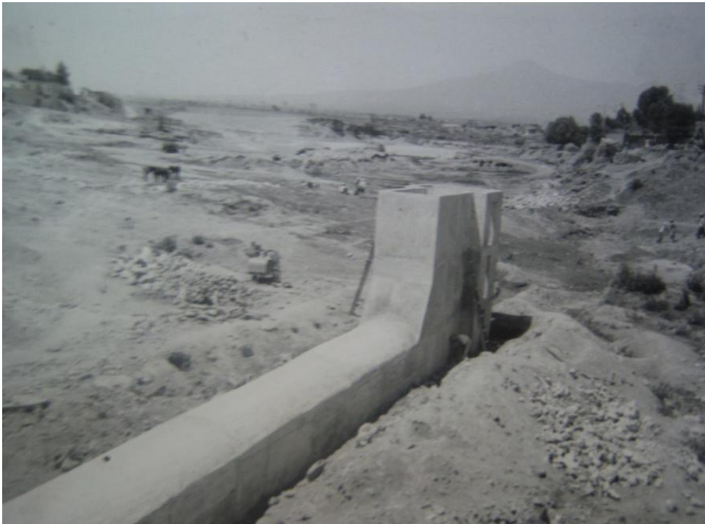
CONSTRUCCION DE LATORRE DEL DIQUE NIÑO ARTILLERO (VASO DIAGONAL) 1965
