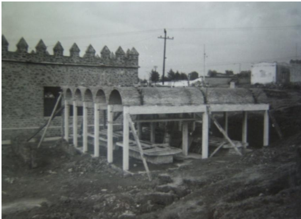
CONSTRUCCION DE LOS LAVADEROS PUBLICOS EN LA DIAGONAL SANTUARIO 1965
