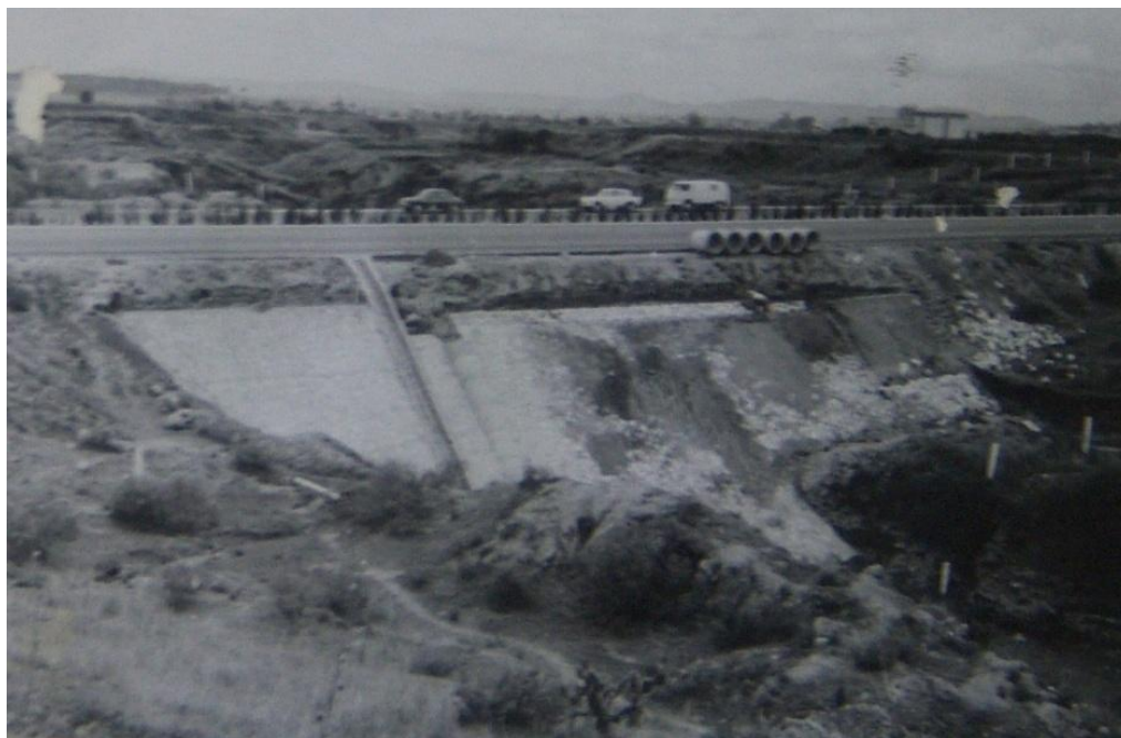
COSNTRUCCION DEL TALUD DE LA BARRANCA SANTUARIO, AUTOPISTA MEXICO-ORIZABA 1965
