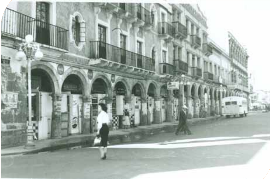
Avenida 16 de septiembre, el portal Juárez con las columnas cubiertas de puestos semifijos y de anuncios diversos, que en conjunto dan un aspecto deplorable. Fotografía: Ramón Pablo Loreto Muñiz. AGMP, Expedientes, vol. 2168, leg. 325, 1960.
