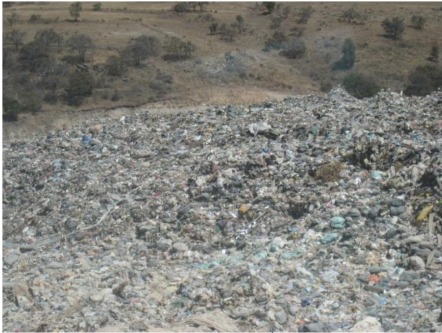
Falta de cobertura en al Área A
