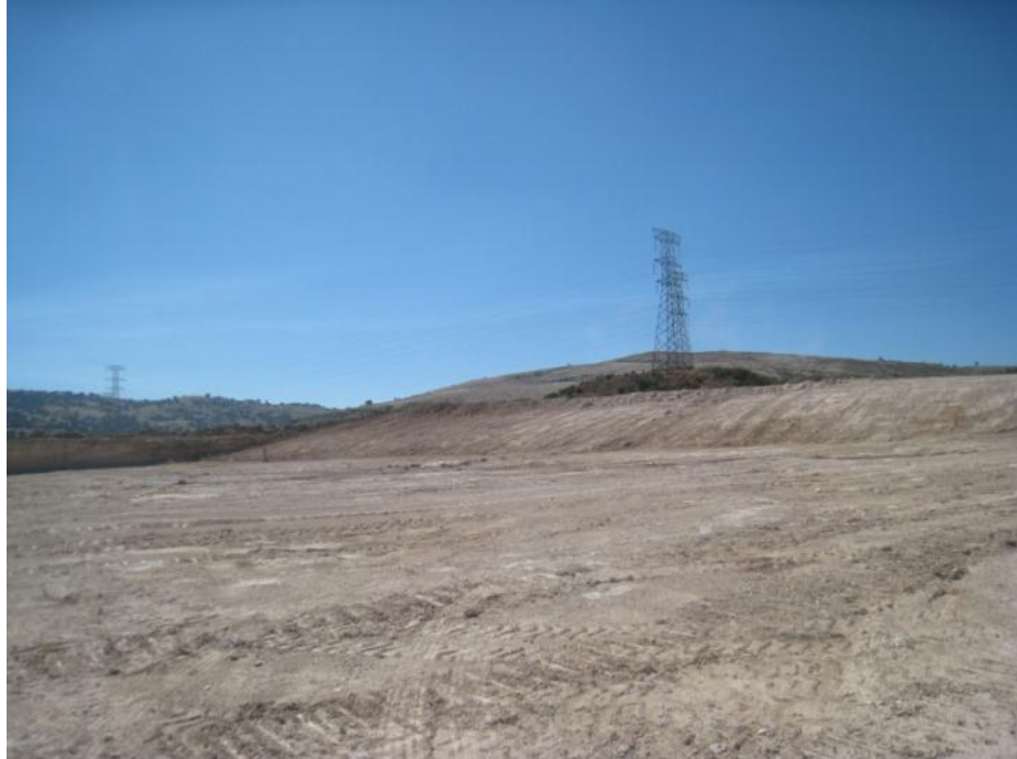
Cubierta en el Área A.
