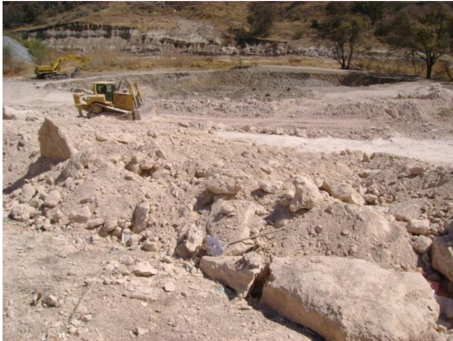
Excavación de áreas de emergencia fuera del Proyecto Ejecutivo
