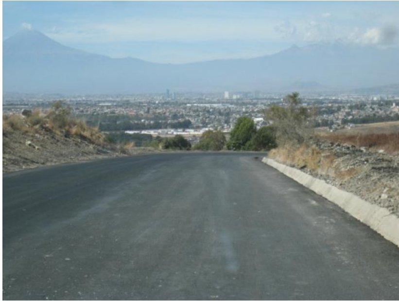
Camino de acceso reconstruido
