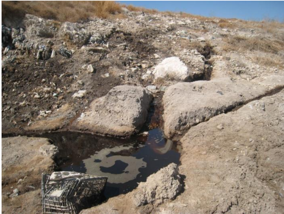
Fuga de lixiviados en la celda 6A.
