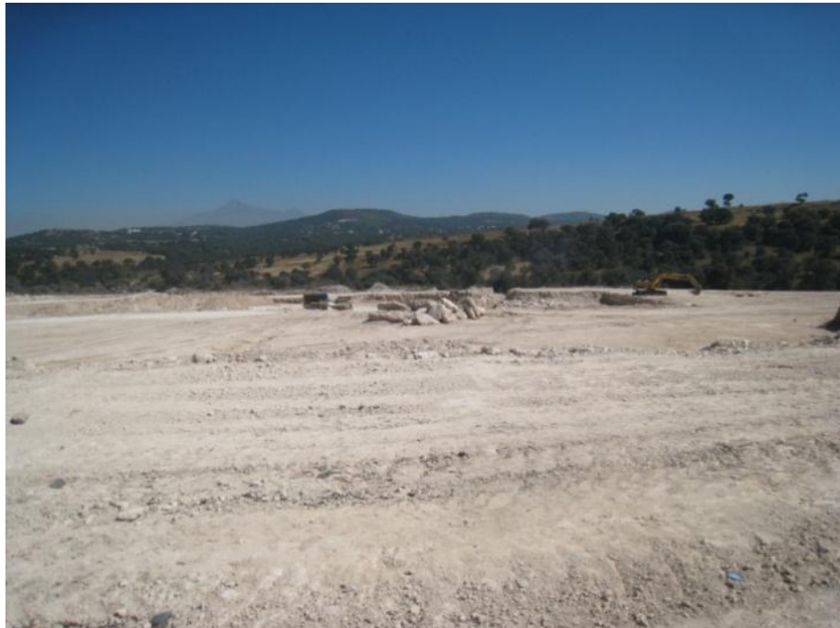
Cubierta en el Área A.
