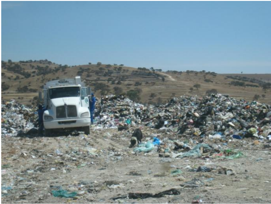
Falta de maquinaria en el frente de trabajo para acomodo y cobertura de residuos
