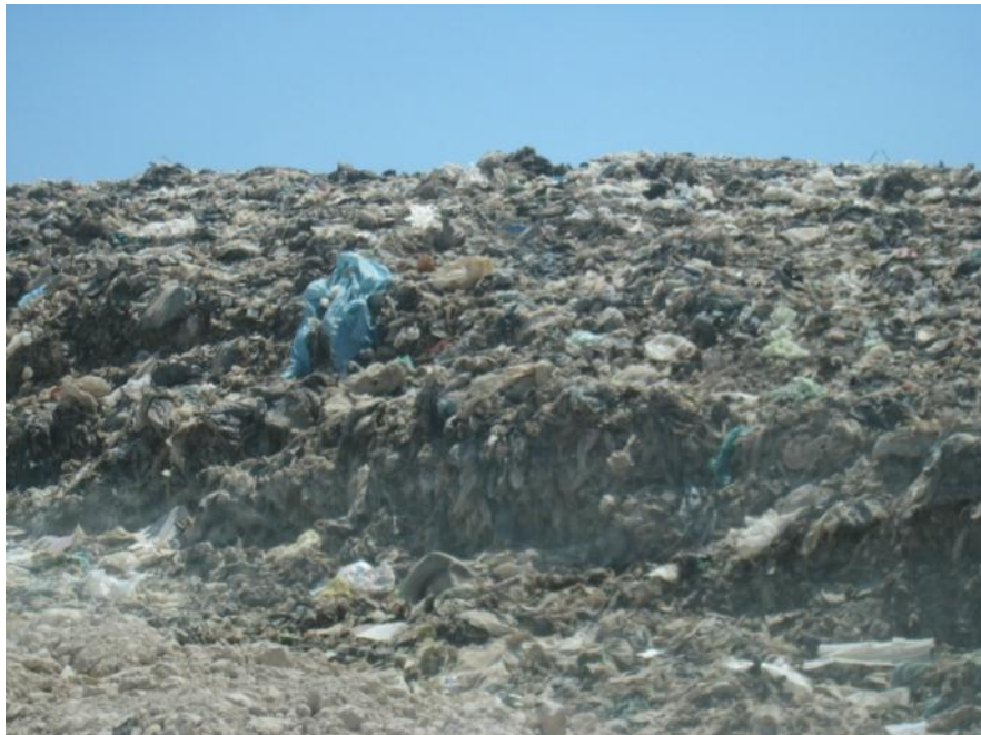
Falta de cobertura en el Área A
